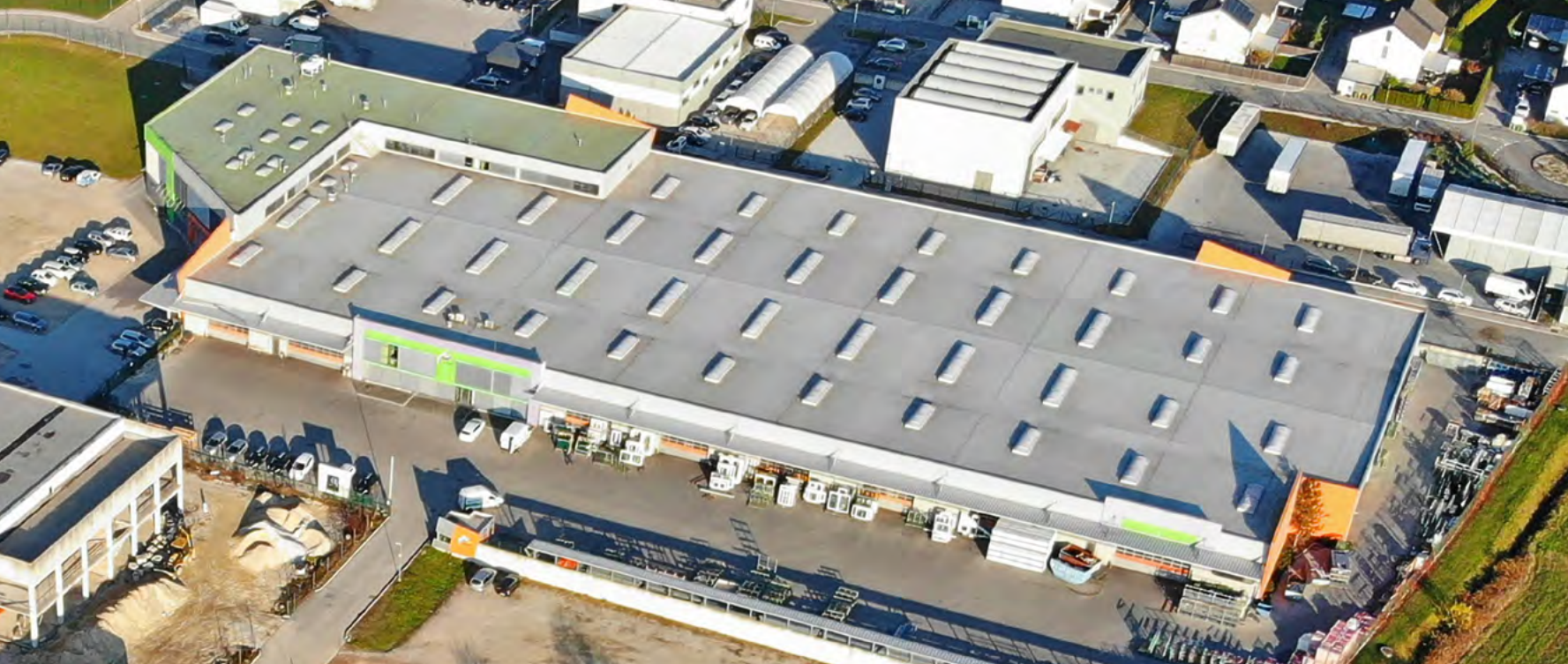
Proizvodnji objekt stavbnega pohištva MIK Celje
