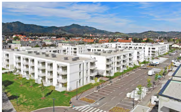
Stanovanjsko naselje Pod Pekersko gorco, Maribor
