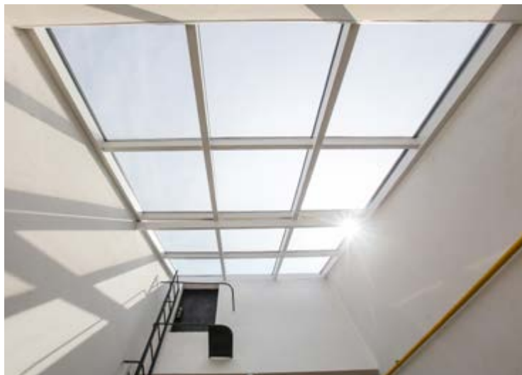
Strešna zasteklitev v večstanovanjskem bloku, Celje
