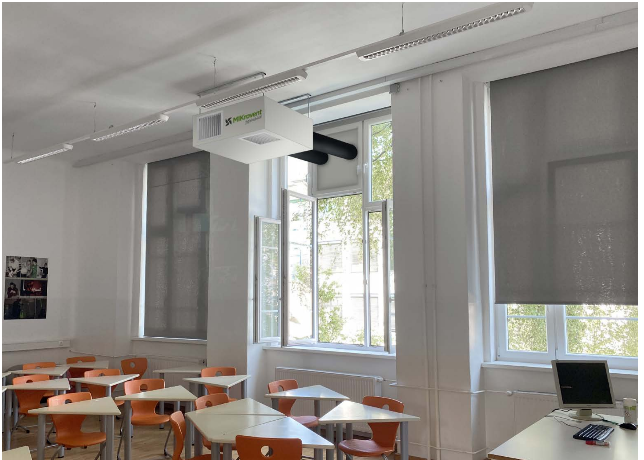
Umestitev sistema Smart MIKrovent v učilnicah Gimnazije Celje - Center
